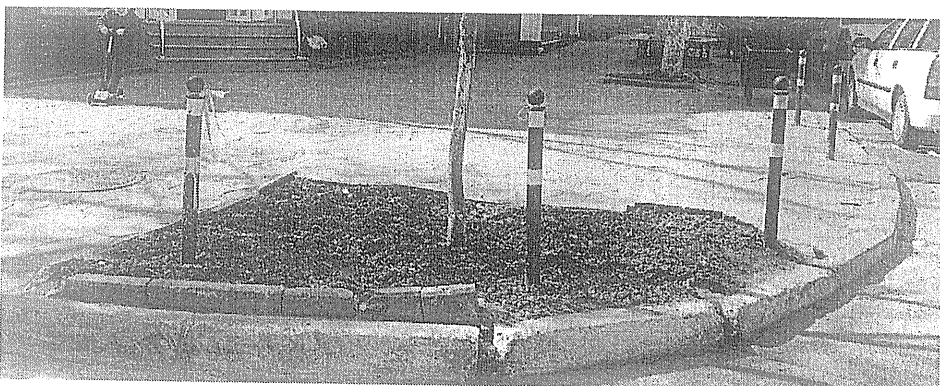
Construcție de bordură existentă
