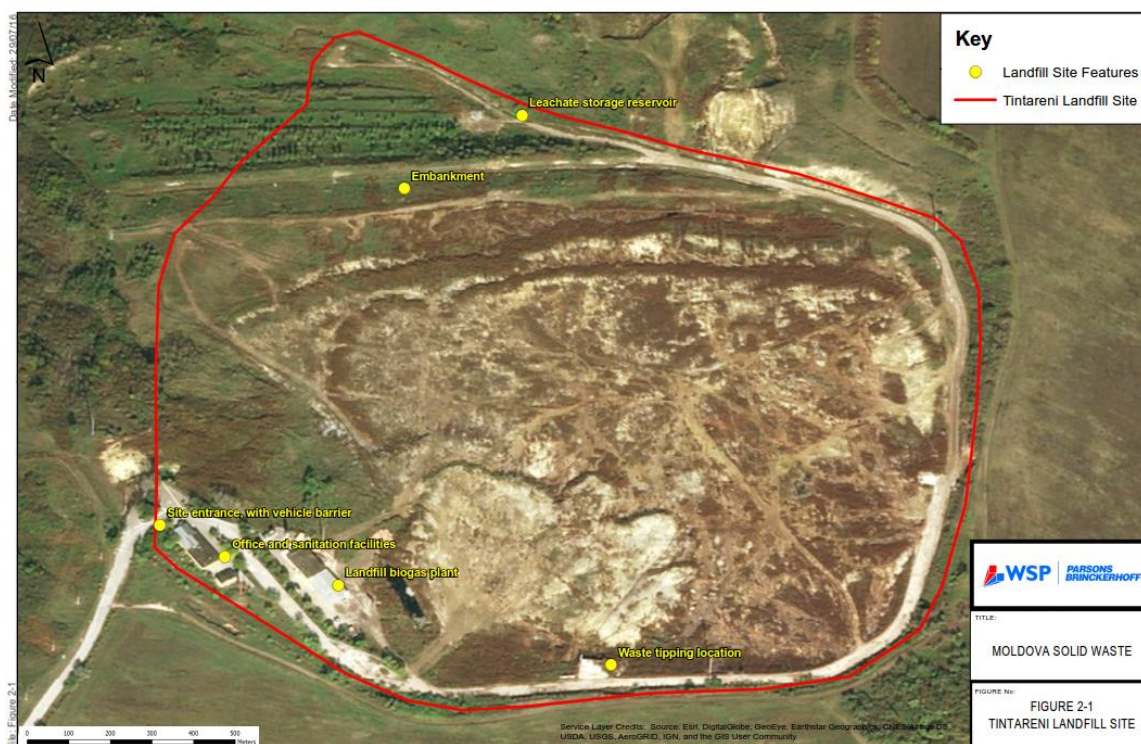
Figura 2-1 Fotografie aeriană a rampei de gunoi existente de la Țânțăreni
