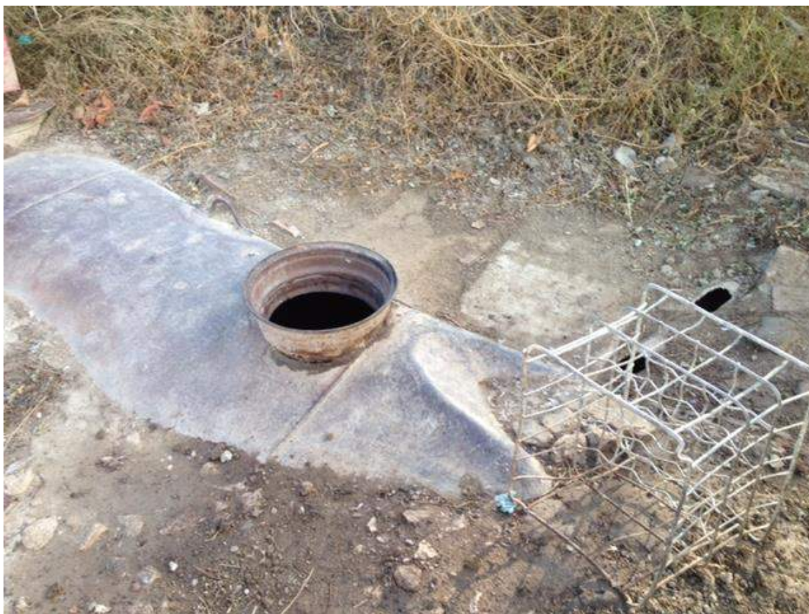
Figura 1-7 Rezervor pentru colectarea levigatului
